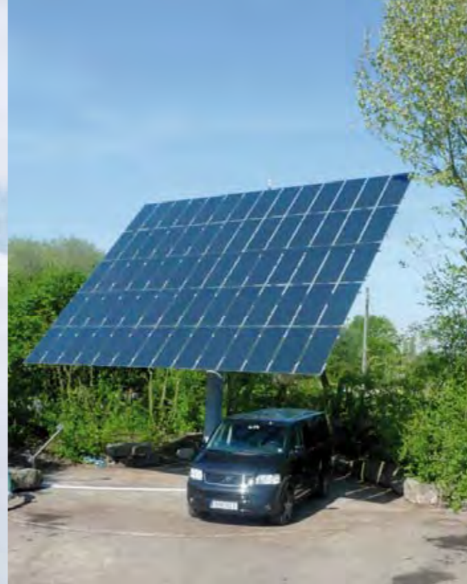
Wie eine Sonnenblume folgen die Solarmodule dem „Kraftwerk“ Sonne. Die Wirkung ist beeindruckend: 40 Prozent mehr Energieertrag als bei herkömmlichen Photovoltaikanlagen.
