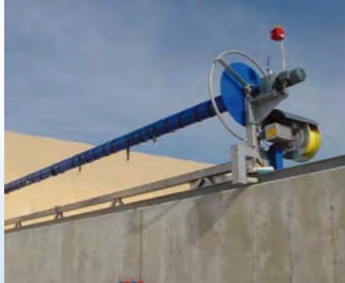
Wickelgeräte aus dem Hause der UTV AG erhöhen die Lebensdauer des GORE® Covers.
